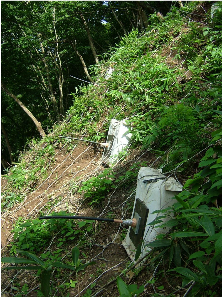
落石対策用ネット併用箇所
