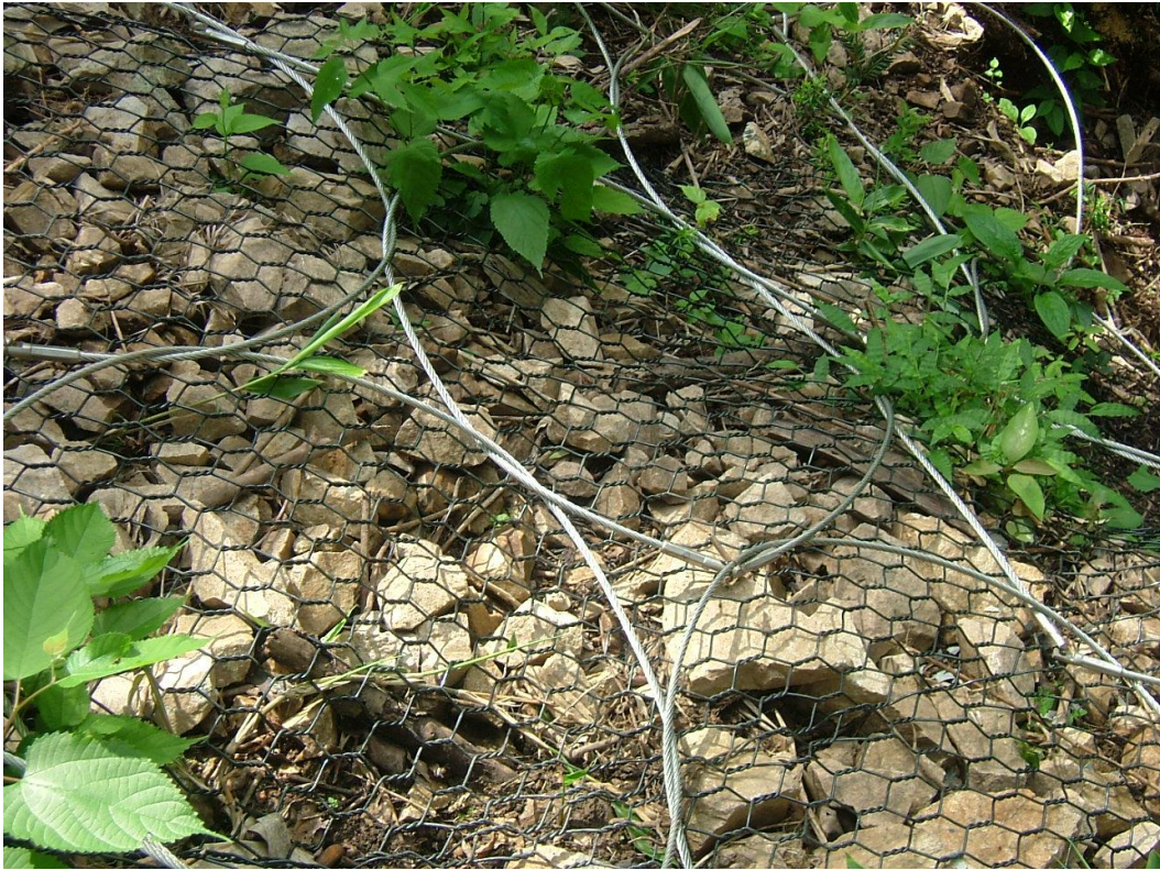
落石対策用ネット併用箇所
