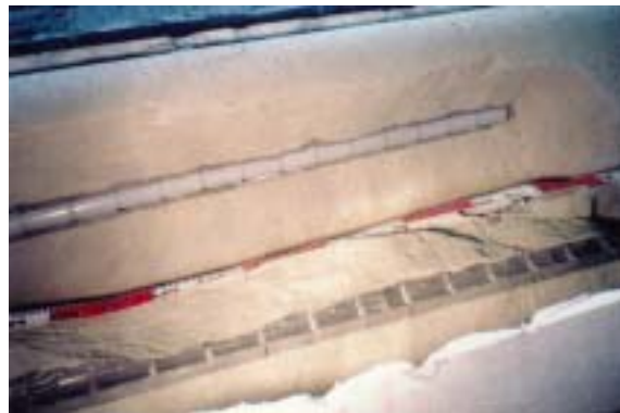
写真 1 くさび方式のアンカー体解体状況
