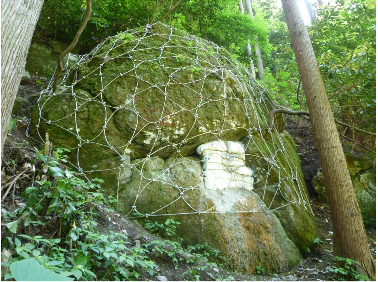
圧入マット式根固工施工例
