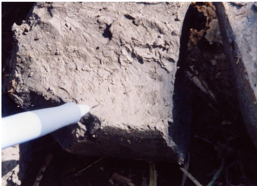
写真 1.6.1 摩擦型アンカーの引抜け要因となりやすいアンカー孔壁の粘土化状況（泥岩： q_u=1.1\text{N/mm}^2 ）
