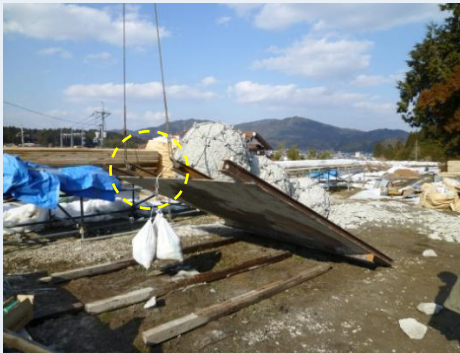
①アンカー取り付け状況(土嚢45kg)
