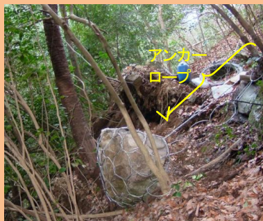
② 転落防止用アンカー取り付け
