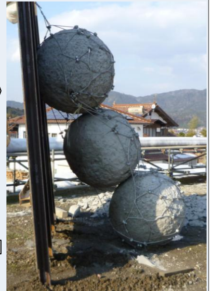
③鋼板をさらに吊り上げた状態
