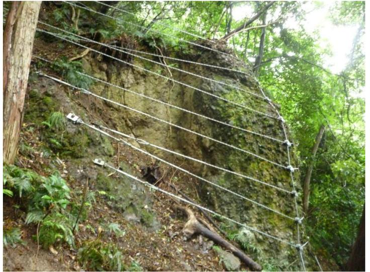
写真-2.3.1 ロープ掛工の施工例
