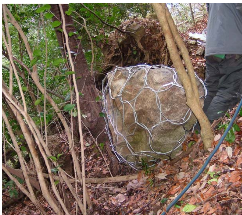
② 石を小割専用ワイヤーネットで巾着状に包む ③ 立木等にワイヤーロープで固定する
