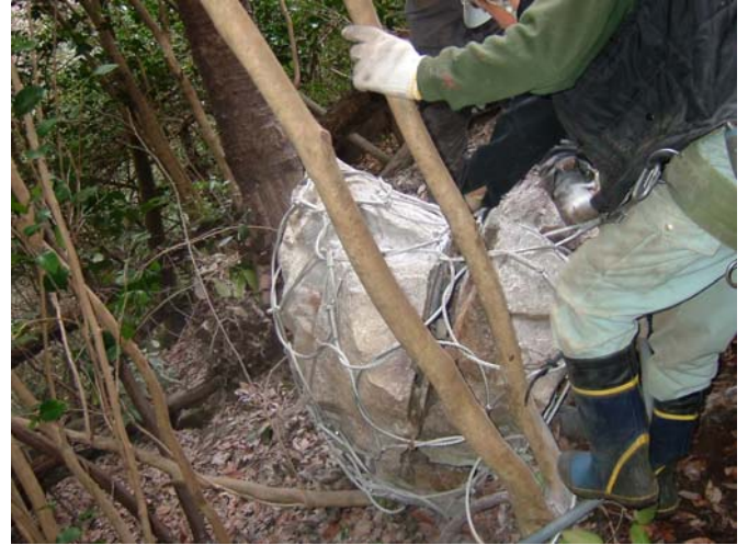
⑤ 小割専用ワイヤーネット内での小割作業（ 安全性の確保 ）
