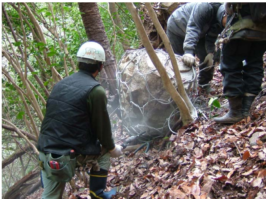
④ 小割専用ワイヤーネット を石に固定するための特殊 アンカーピン取り付け作業
