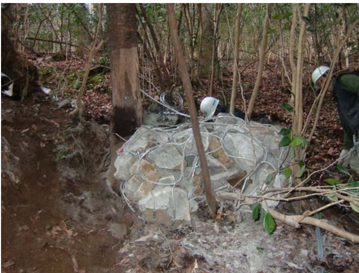
⑤ 小割専用ワイヤーネット内での小割作業（ 安全性の確保 ）
