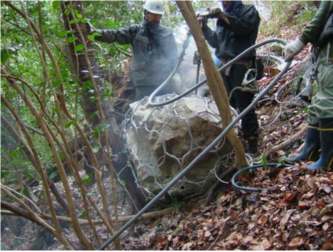
⑤ 小割専用ワイヤーネット内での小割作業（ 安全性の確保 ）
