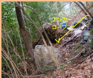
② 転落防止用アンカー取り付け
