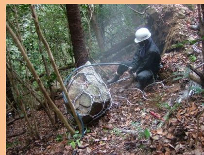
③ 転石とワイヤーネットを一体化するためのアンカーピン打設(非小割領域)
