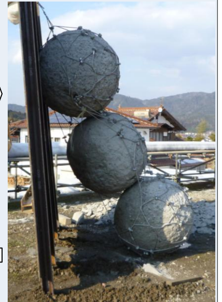
③鋼板をさらに吊り上げた状態
