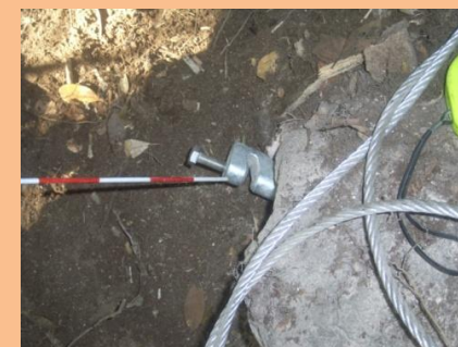
③ 転石とワイヤーネットを一体化するためのアンカーピン打設(非小割領域)
