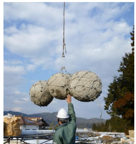
ワイヤーリング1ヶで3.6tを吊り上げた状態
