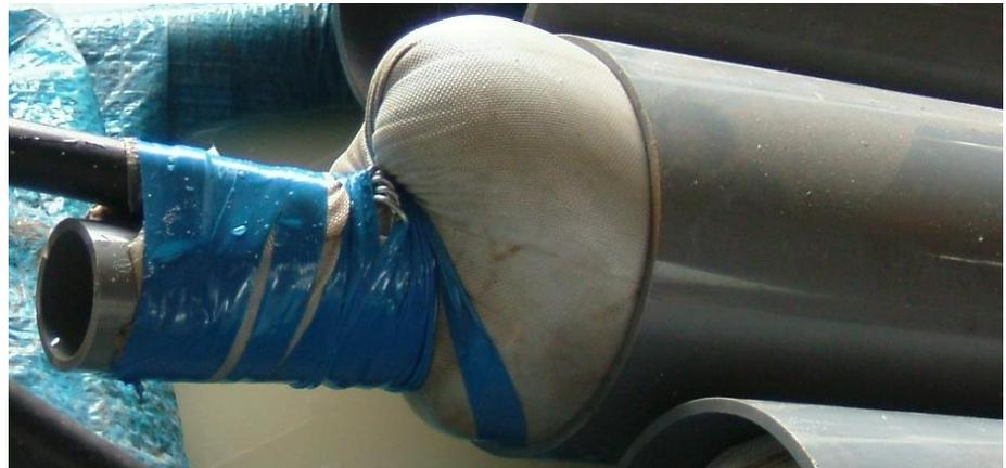
孔内水やエアが十分排出され、パッカー内がグラウト材で充填された状態。
