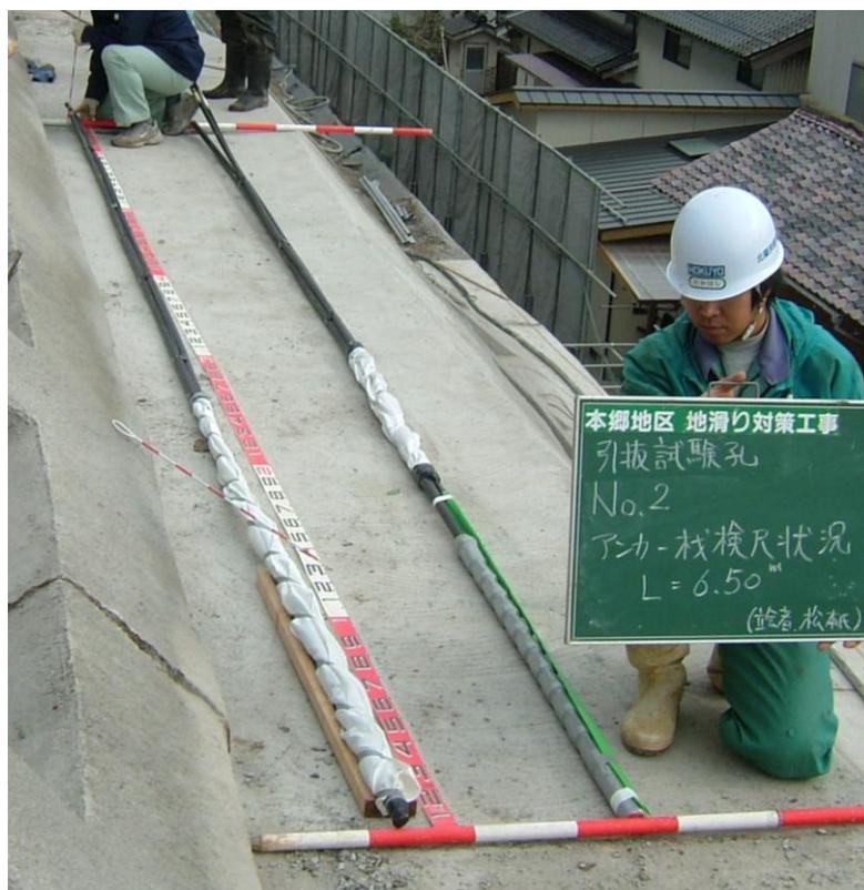
写真 1 試験用アンカー体組立加工状況 (300Ws 型)
