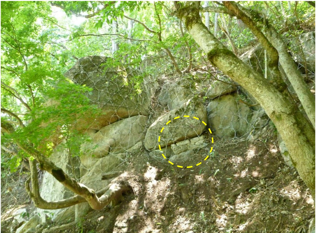
○巨岩を含む落石源の固定（下方より撮影）：根固めマット併用
