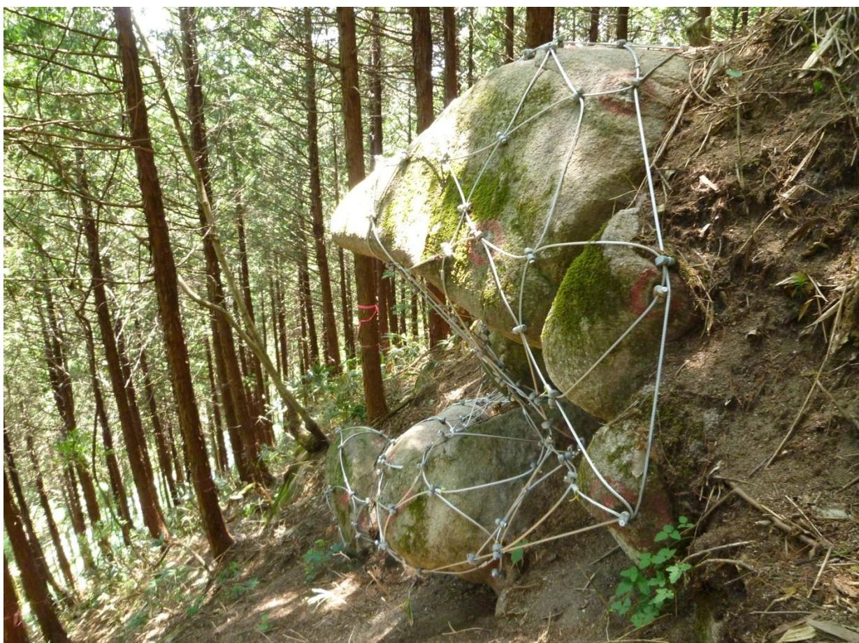
○巨岩固定例（施工時に変位したため仮設水平ロープを取り付けた）
