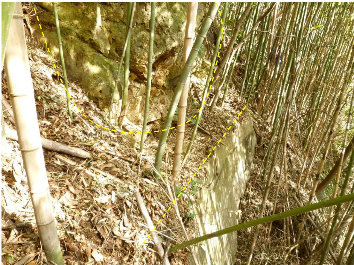
○モルタル吹付・・・床堀することなく、空隙部を充填し、ワイヤーネット等で補強。
