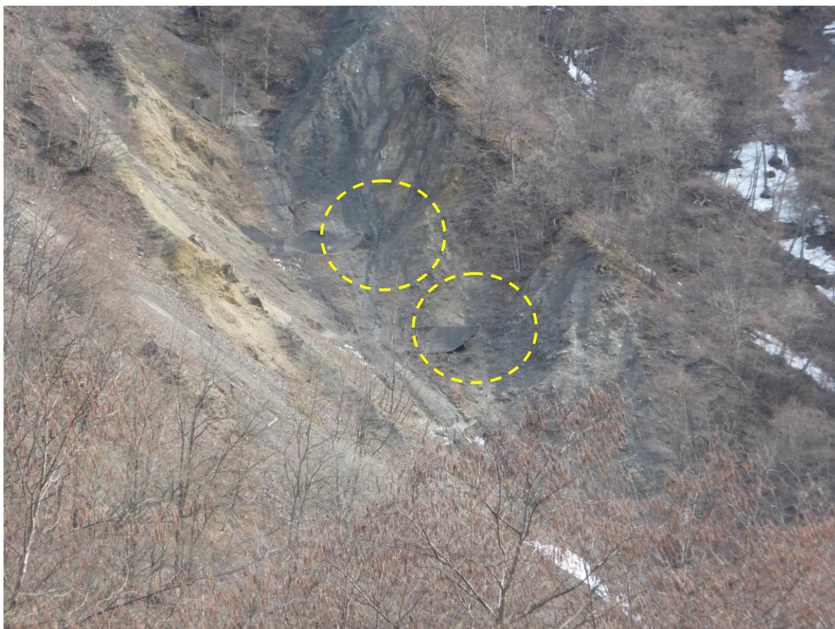
○上記，堰堤群の袖部が浸食されている
