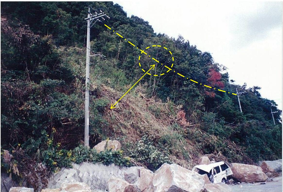
○落石の軌跡…最大傾斜方向に対して、左右 20~25° のブレを生じながら転落（跳躍巾 3~5m）。
