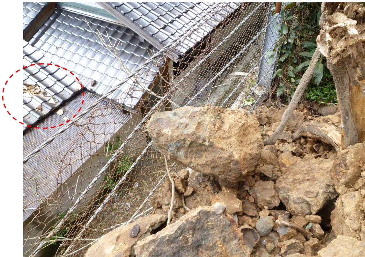
○抜けだし (流れ盤状の節理に規制され転落. 防護網を突き破る)
