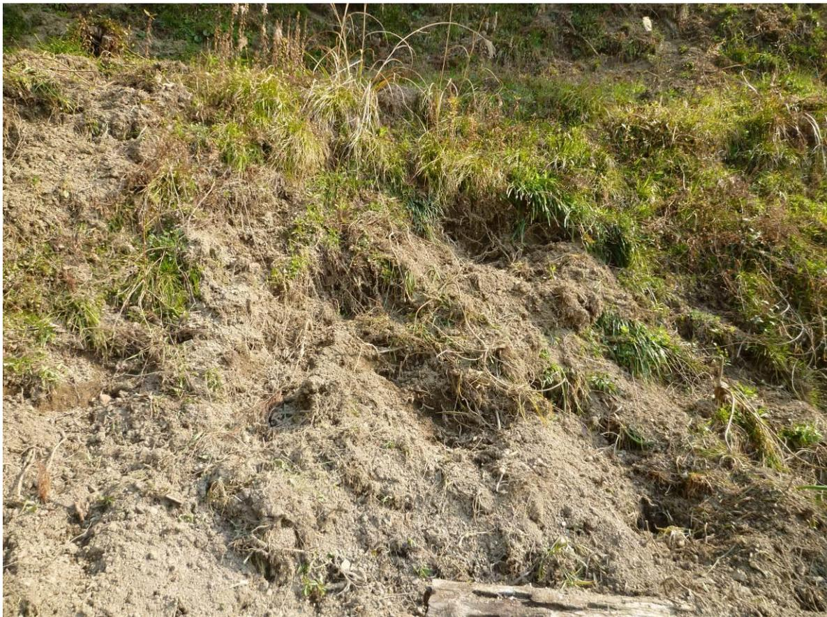
○地すべり・・・落石対策がなされているが，後背斜面の地すべりを抑止しない限り，これを防ぐことはできない。
