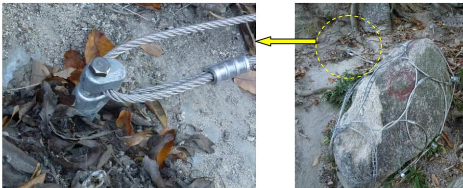
写真-4.1.2 アンカーピンで小岩塊を固定した例（ワイヤーリング径 35cm）
