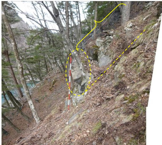
写真-4.1.4 退行性浸食（浮石後方斜面の緩み状況）の例
