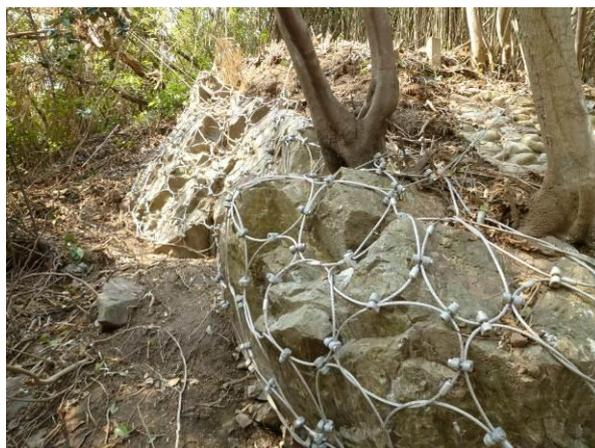
写真-4.1.1 敷設したワイヤーリングの変形状況
