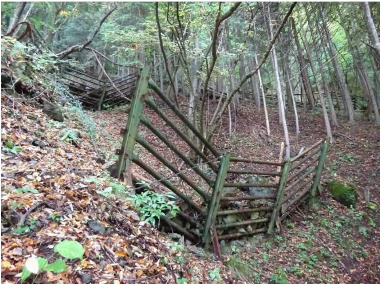
雪崩防護柵（自在性有り：飛騨市）
