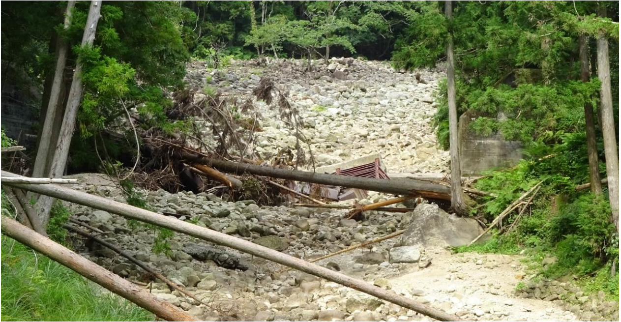
土石流によるスクリーンダムの決壊
