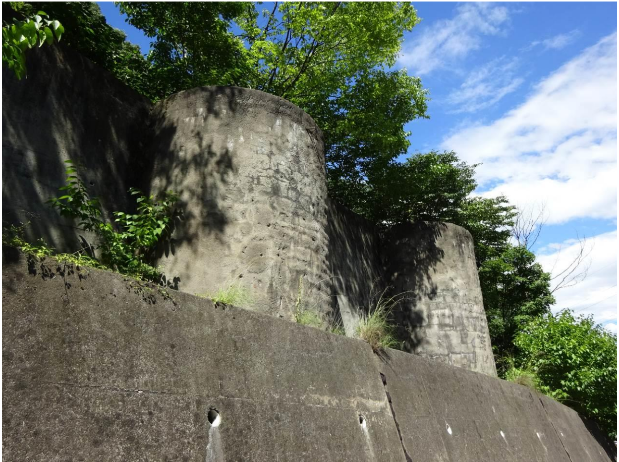
シャフト杭・・・ひび割れが目立ってきたような・・・
