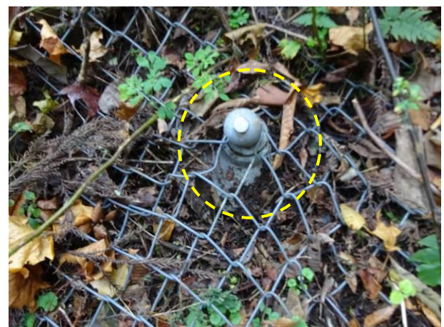
写真一参 2.5.2 移動層脚部鉄筋の引き込み状況
