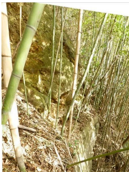
写真-参 1.7.1 根固工の実施例
