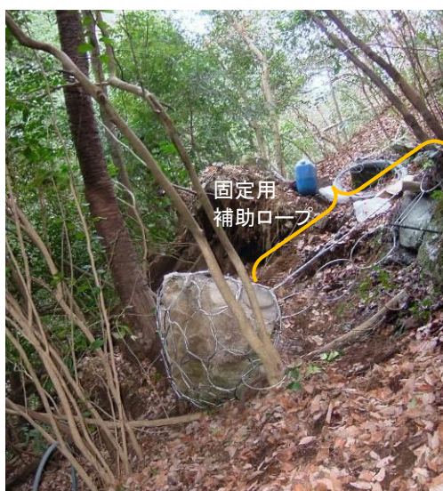
写真－参 2.2.6 小割りする岩塊をワイヤーネット（リング径 35cm）で包み，補助ロープで立木に固定
