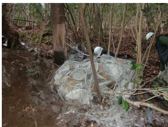
写真－参 2.2.8 安定形状に小割し，そのまま残置（斜面脚部にはポケット式落石防護網が設置されている）
