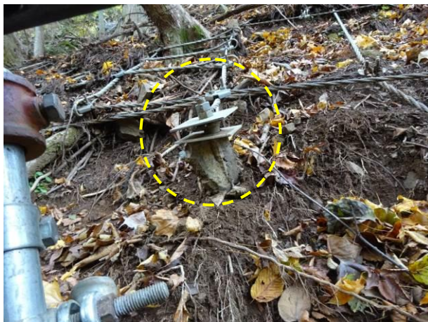
写真一参 2.5.1 移動層中腹部鉄筋の立ち上がり状況
