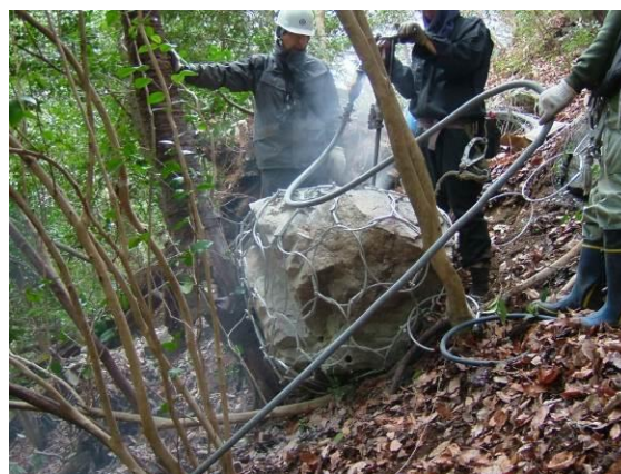
写真－参 2.2.7 ワイヤーネット内での小割作業
