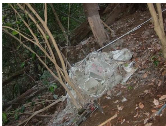
写真－参 2.2.9 必要に応じて補助ロープで固定し，長期的安定を確保する．
