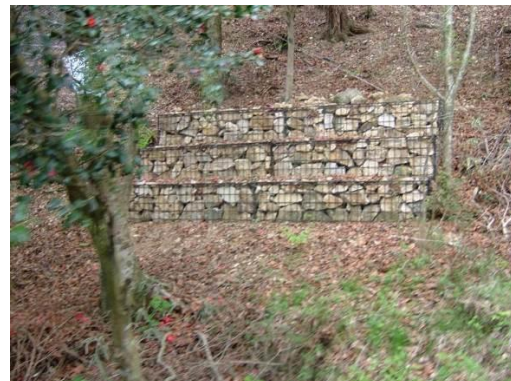
97 写真-参 2.2.5 小割りした岩塊を安全な場所に移し、籠詰めした例
