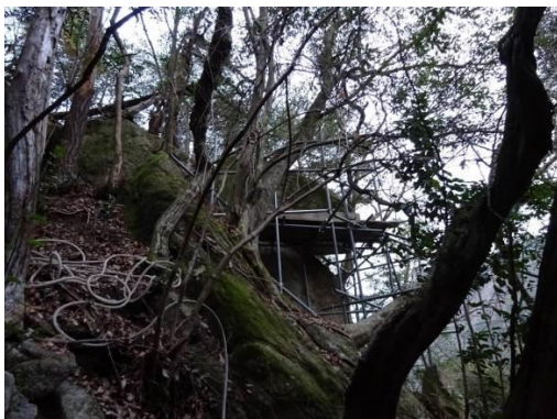
写真-参 2.2.4 単管足場仮設例
