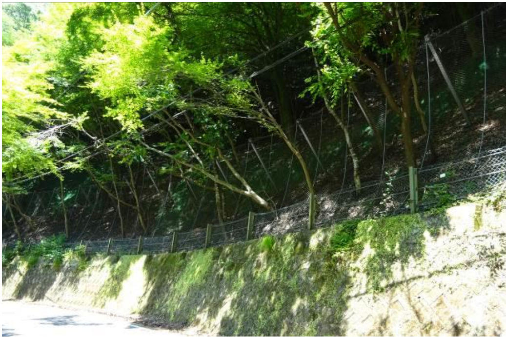
低い防護柵と，その直上におけるポケット式防護ネットとの組み合わせ（箕面市） ・・・後者が，その後の追加補強対策と思われる．ナイス！
