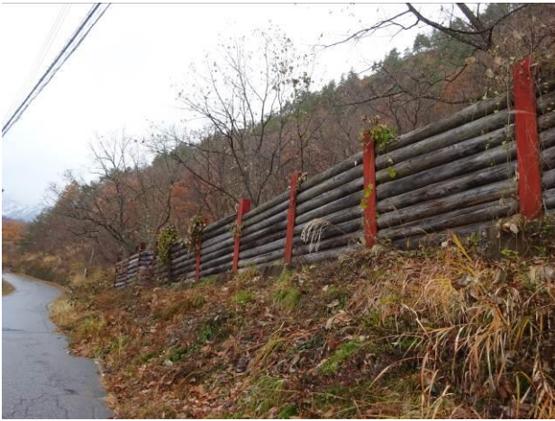
丸太防護柵（長野県白馬村） …丸太は腐植に応じて交換できる。ナイス！
