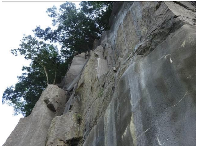
特殊配合モルタル吹付（落石対策：左は吹付前の金網敷設）
