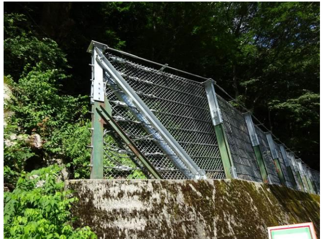
既設防護柵の嵩上げ（木祖村）
