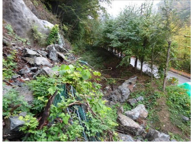
土堤（岐阜県飛騨市）・・・設置区間では確実に捕獲している．用地があれば最善の方法！
