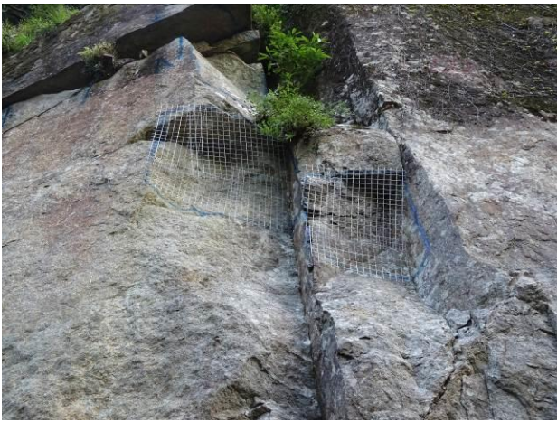
特殊配合モルタル吹付（落石対策：左は吹付前の金網敷設）
