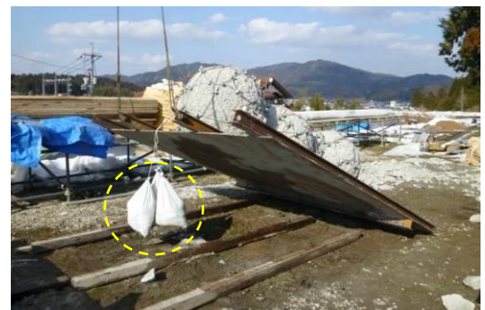
写真-参 4.1.2 アンカー用土嚢袋 (45kg) の取り付け状況
