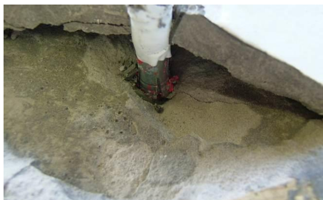
写真-参 4.3.4 拘束具引抜き直前状態
