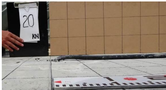
PC 鋼より線の曲がりおよび コンクリートの剥離状況等の観察
