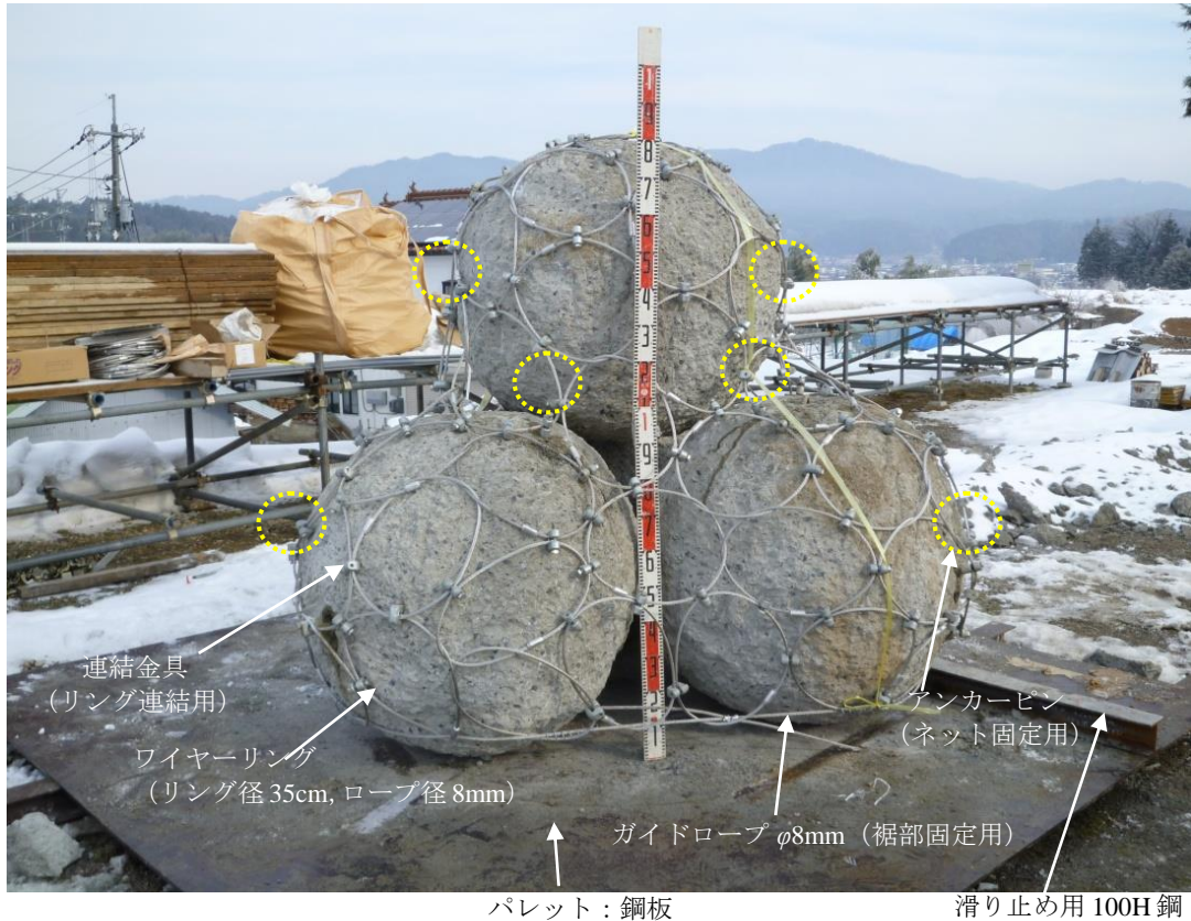
写真－参 4.1.4 転倒実験用試験体（コンクリート球 4 個）組み立て状況
