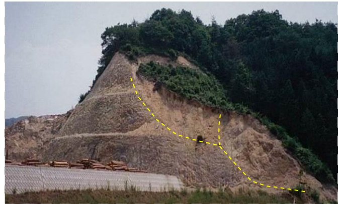
写真9 地すべり断面（豪雨災害時に発生）
