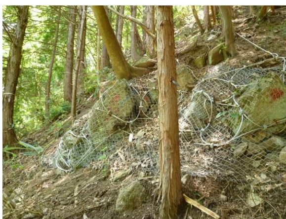
写真-参 3.1.6 小岩塊対策として金網併用例
