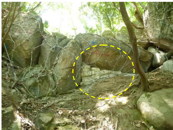
崖錐上の転石を根固めした例
