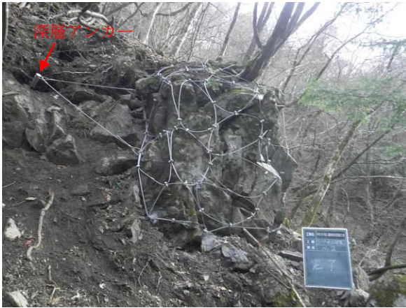
写真-参 3.1.7 浮石の固定 (緊急対策)
