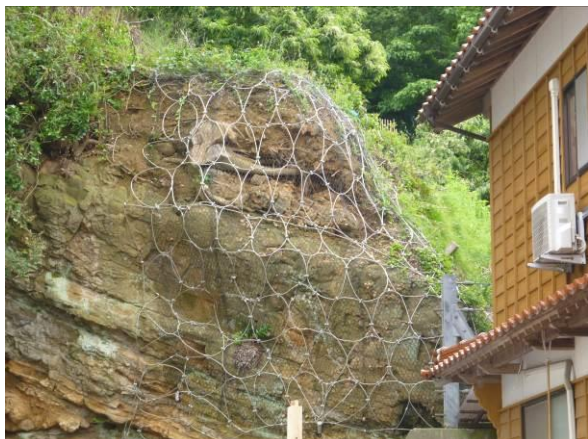
写真-参 3.1.3 オーバーハング箇所の固定例 (樹脂製ネット併用)
