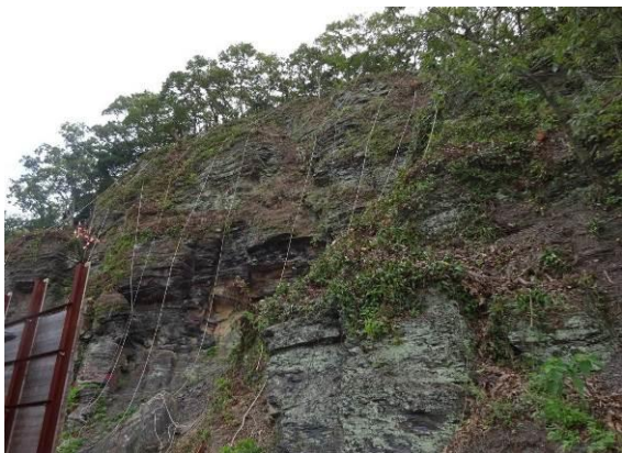
岩盤崩落（斜面長 20m, 傾斜 70~75°） …アンカーはスカイドリル工法にて施工
