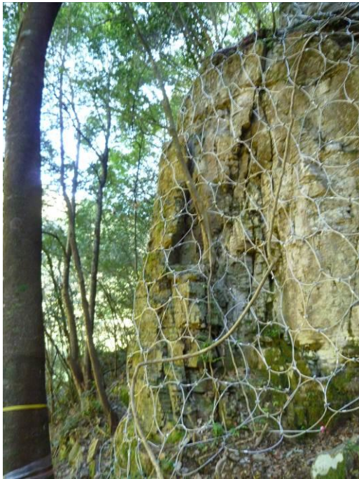
写真-参 3.1.9 バックリング状態の露岩
