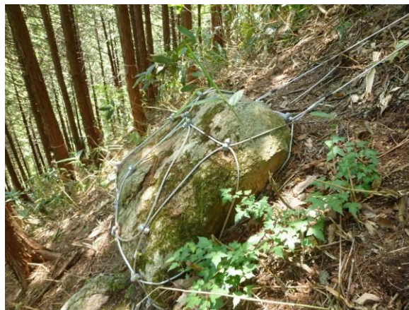
写真-参 3.1.4 小岩塊の固定例
