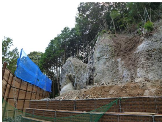
小割完了 (転倒安全率確保)
