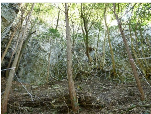
写真-参 3.1.5 剥離性露岩を面的に被覆した例 (立木はすべて残している)
