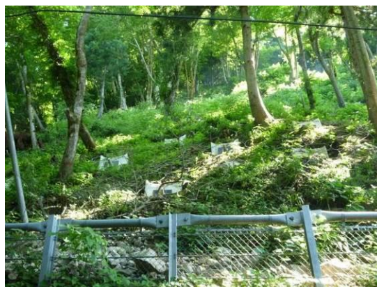
層厚 3~5m の表層すべり（中腹部押し出し）
