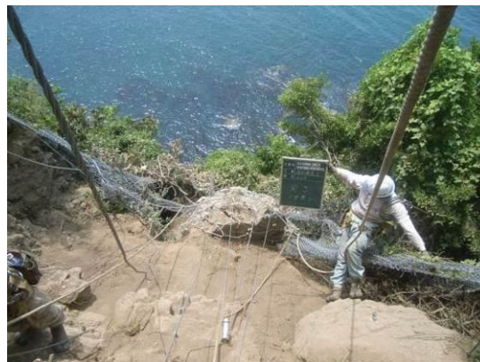
写真-参 3.3.2 被災した防護ネットごと、ワイヤーネットでも巾着状に包む
