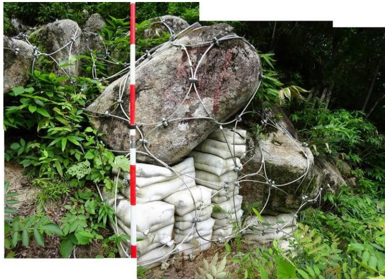
浮石脚部侵食部への充填例
