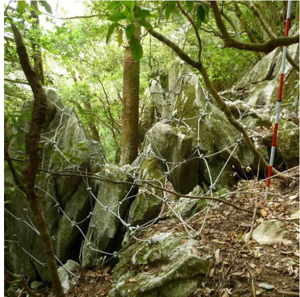
写真-参 3.1.10 凹凸の激しい転石群を被覆
