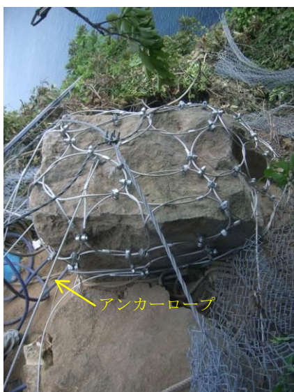
写真-参 3.3.3 アンカーロープで固定
