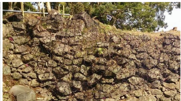
写真-参 3.1.12 文化財 (城の岩塊垣) の補強 (景観保持のため、ネット着色)
