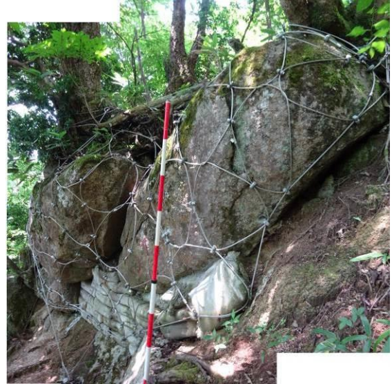
浮石脚部侵食部への充填例
