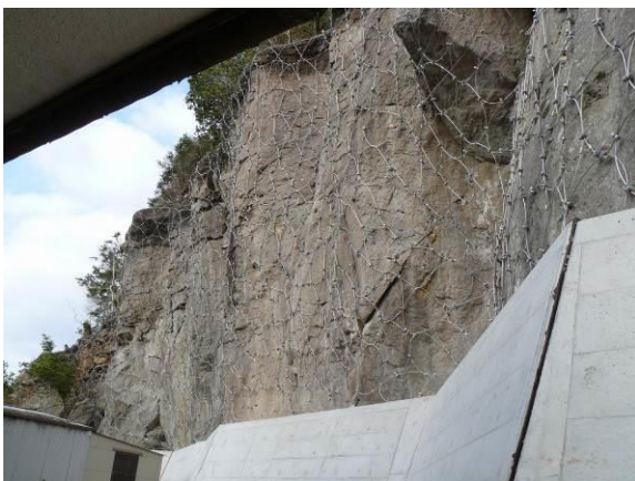
写真-参 3.1.11 垂直壁の固定 (根固工併用)
