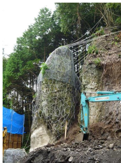
ワイヤーネットで被覆し、深層アンカーで頭部を固定 (転倒防止)
