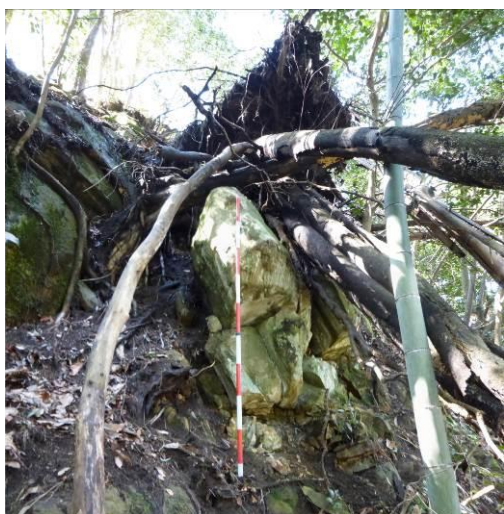
写真-3.2.2 倒木による岩塊の剥離
