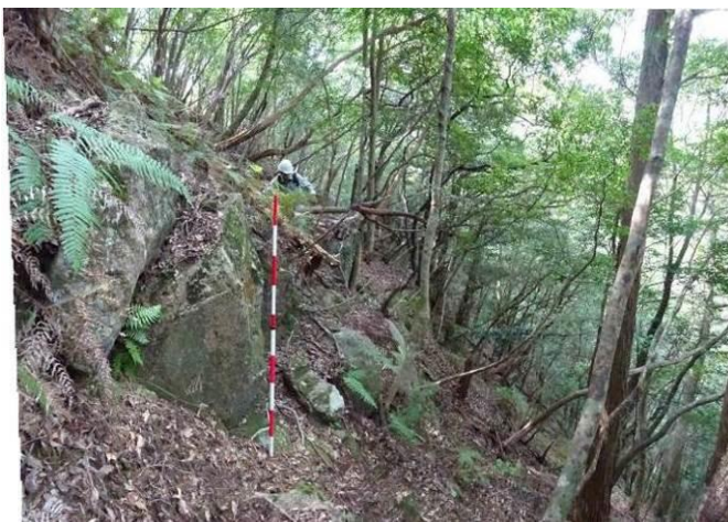
写真-3.2.10 表層すべりにより浮き出た岩塊群
