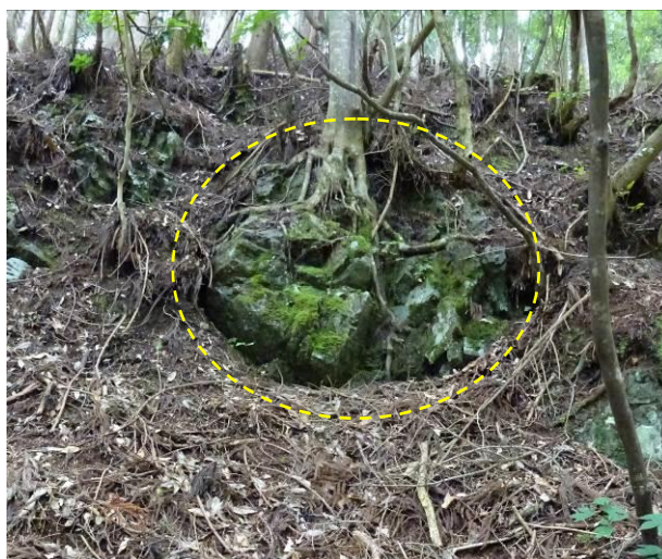
写真-3.2.3 同左、危険を予測すべき浮石
