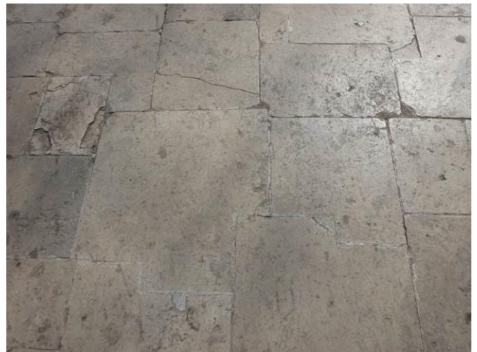
路盤敷石（異なる形のもの貼り付けている）
