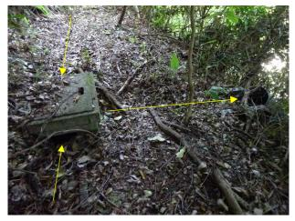
二次製品を設置するより、土水路状のもの(漏水防止用底張り付)に暗渠管( $\phi$ 10~20cm)を載せたような構造が適当では?
