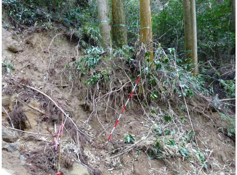
② 溪岸浸食厚：最大 3m 程度
