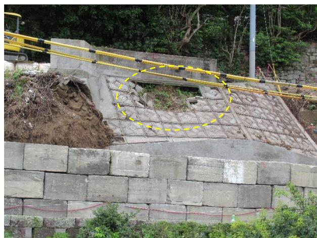
法面工下位地盤の浸食による被災
