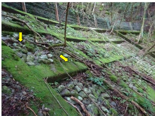
枠内石詰めめの沈下／ハラミ
